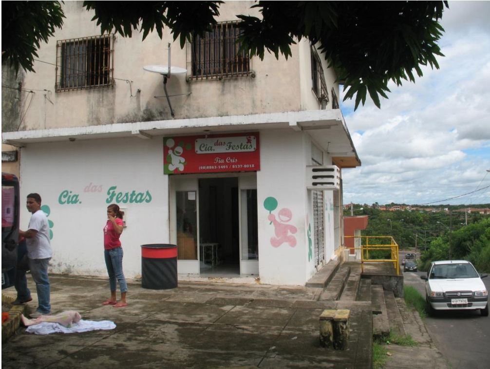
Foto 08: Rua 101, Quadra 79, Casa 01, Conjunto Vinhais
