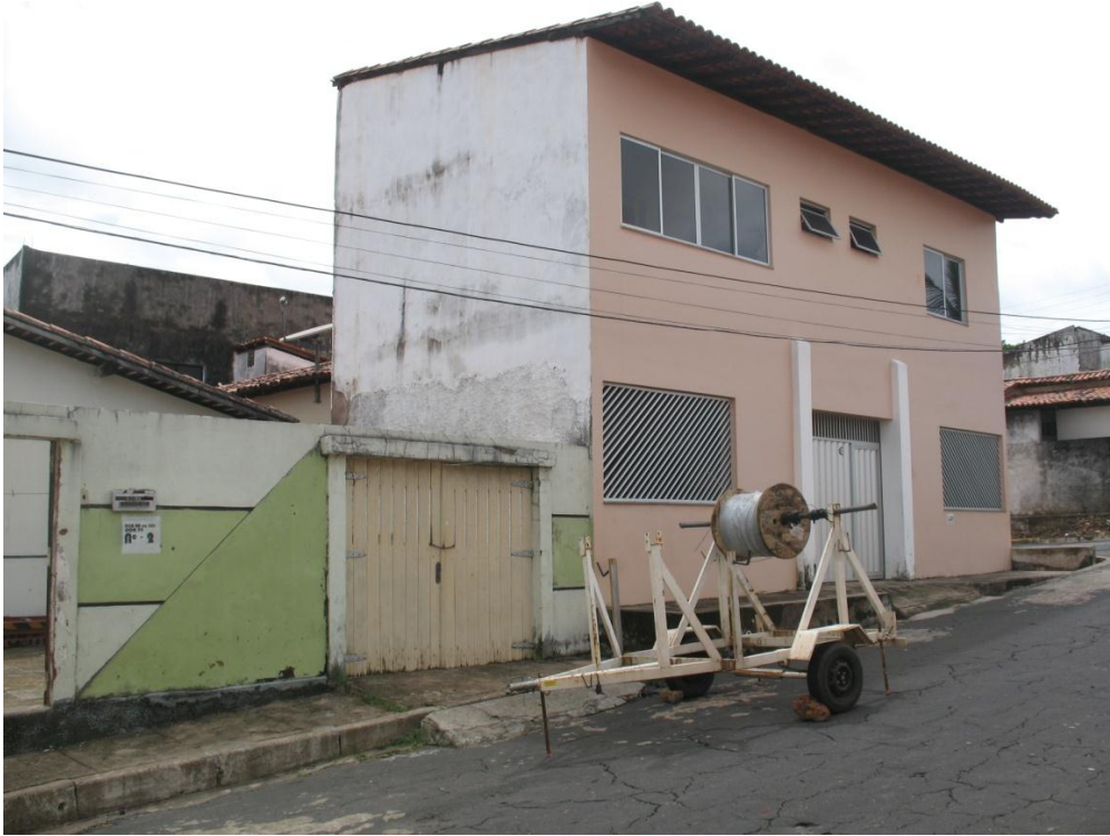
Foto 10: Rua 101, Quadra 79, Casa 01, Conjunto Vinhais
