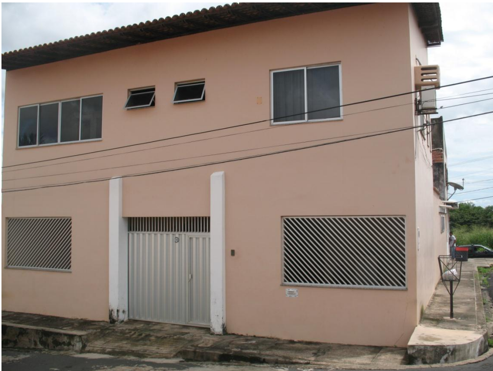
Foto 09: Rua 101, Quadra 79, Casa 01, Conjunto Vinhais
